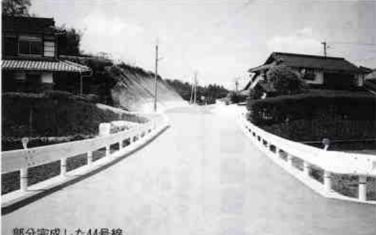
部分完成した44号線
